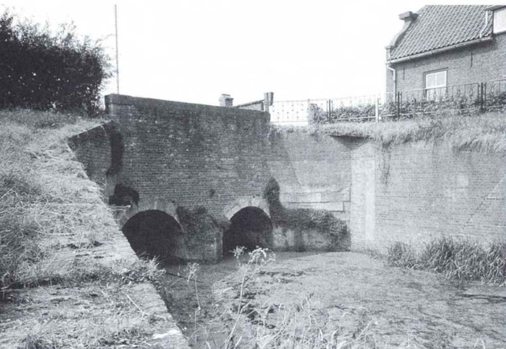
De Blauwe Sluis in de Maasdijk te Gewande, gezien vanaf de Hertogswetering. Al eeuwenlang bevindt zich een sluis op deze plek. (Foto: BAM)
